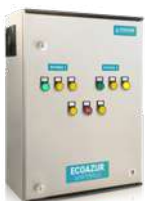
VACIADO DE CÁRCAMOS
